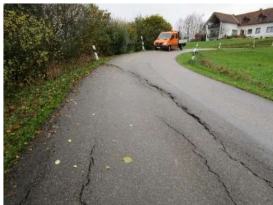
Gemeindestraße im Bereich Stolzhof - vorher
