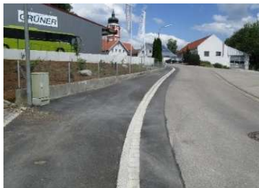
Gehweg an der Friedhofstraße - nachher (April 2021)
