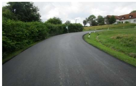
Gemeindestraße im Bereich Stolzhof – nachher (Juli 2021)
